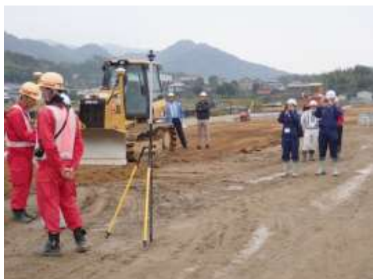
ICT 土工の現地説明
